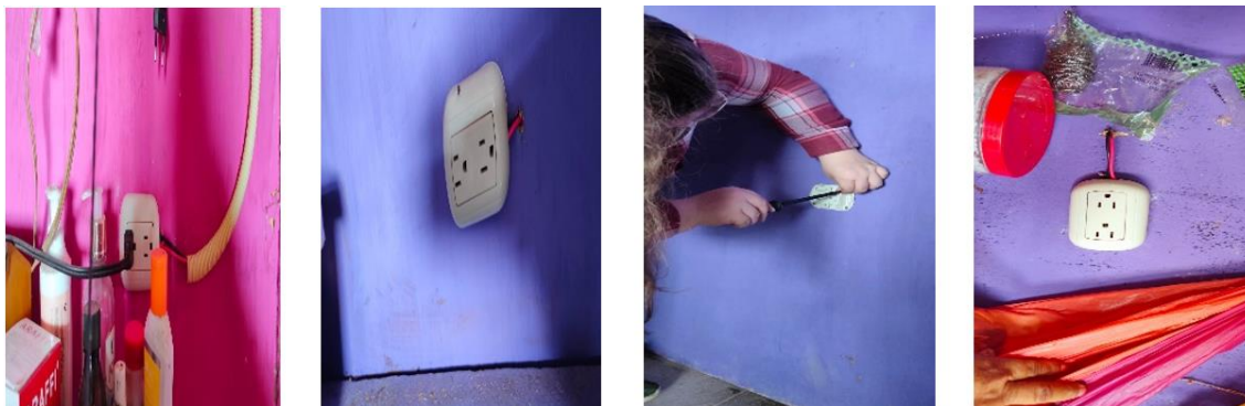
Figura 29.- Instalación de tomacorriente
