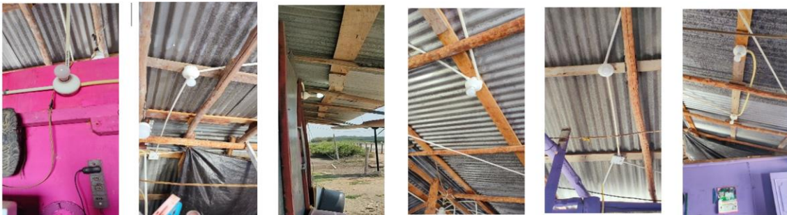
Figura 28.- Instalación de luminarias
