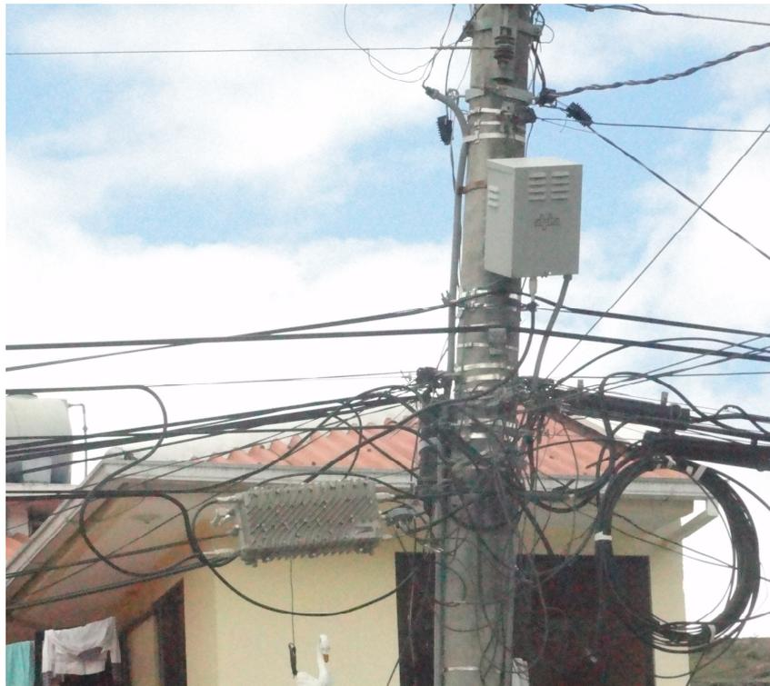
*Figura 3.27. Nodo óptico colocado en un poste de energía eléctrica* <sup>[1]</sup>
