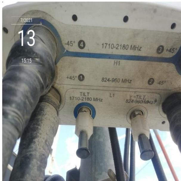
**Figura 2.11:** Antena sectorial con diversidad de frecuencia
