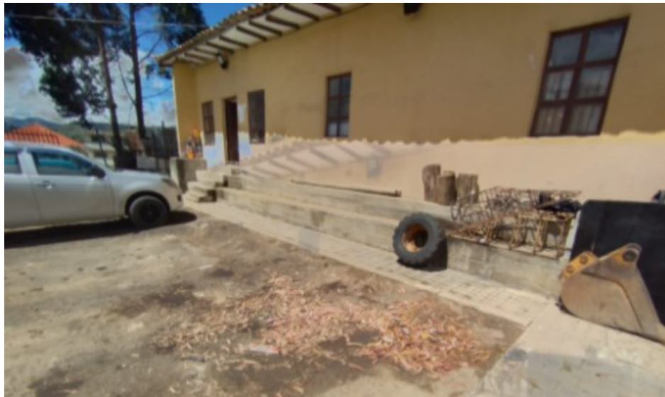
Figura 6: Falta de Señalización del Canchón
