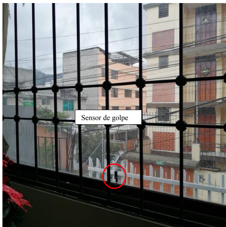
Figura 70. Ventana Posterior al acceso principal del domicilio
