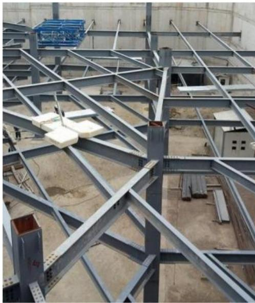
*Nota:* Facilidad de montaje y conexión utilizando pernos. Fuente: Calderón & Velásquez, 2015.
