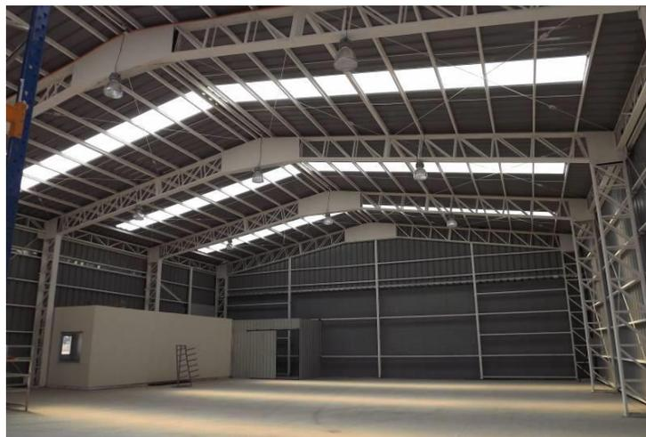
*Nota:* Estructura de almacenaje construida con vigas y columnas tipo cerchas. Fuente: Imagen tomada de internet.
