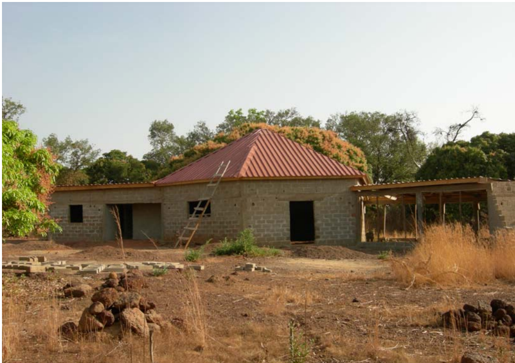
Escuela comunitaria en construcción.
