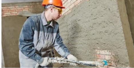
**Figura 5.** Disipado del mortero en la pared de forma horizontal, [17].
