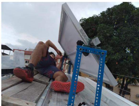
**Figura 3.5** Instalación de paneles solares de 200W con soportes en techo
