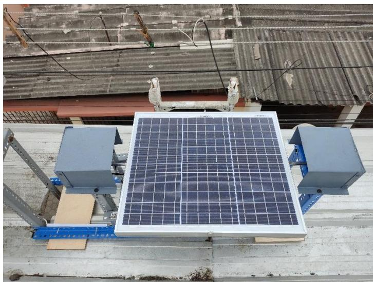
**Figura 3.13** Instalación de panel solar 30W con soportes
