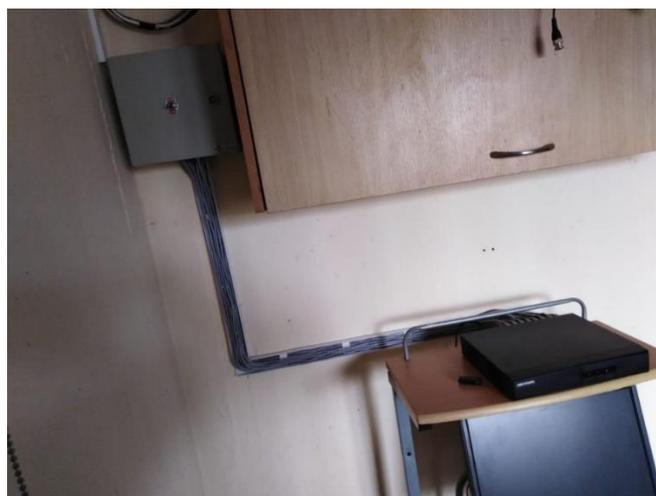
**Figura 3.64** Sistema CCTV instalado con el DVR y monitor.
