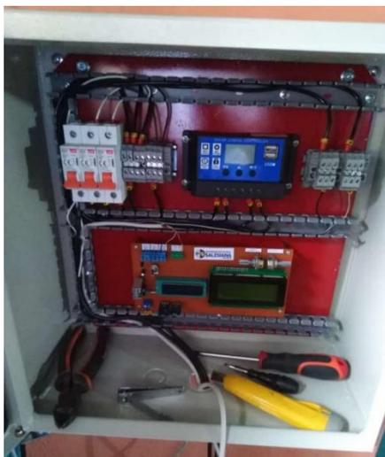
**Figura 3.18** Armado y cableado de la caja de control para sistema fotovoltaico
