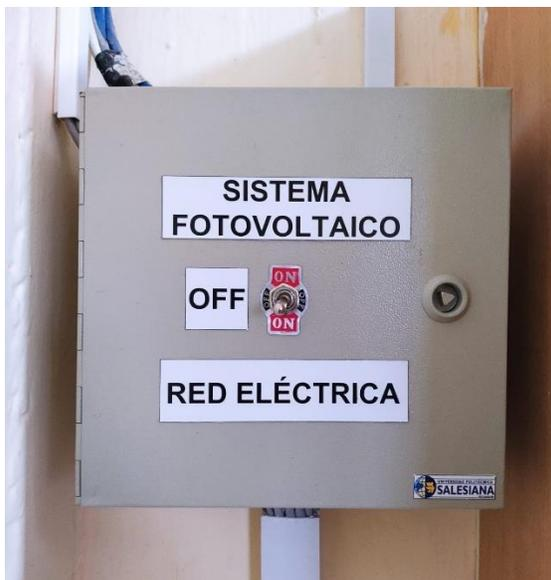
**Figura 3.65** Selector para alimentación del sistema CCTV.
