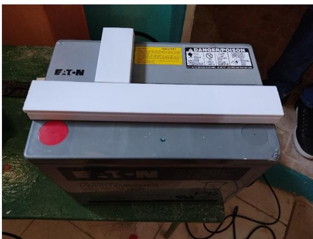
**Figura 3.24** Protección de bornes Batería 70Ah
