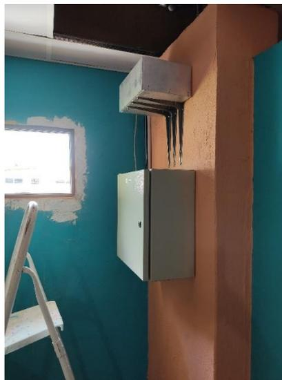
**Figura 3.22** Ubicación de base para Batería 70Ah
