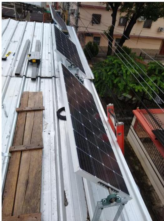
**Figura 3.6** Paneles solares de 200W con soportes instalados visto desde el punto
