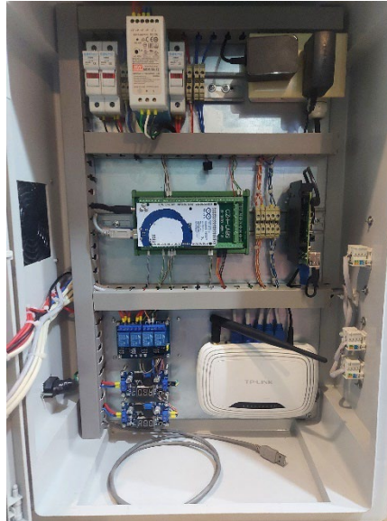
Figura 79: Dispositivos instalados en plafón.
