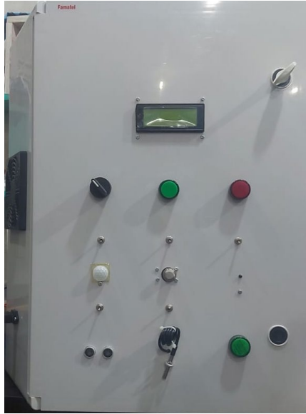
Figura 81: Instalación de elementos en puerta de tablero.
