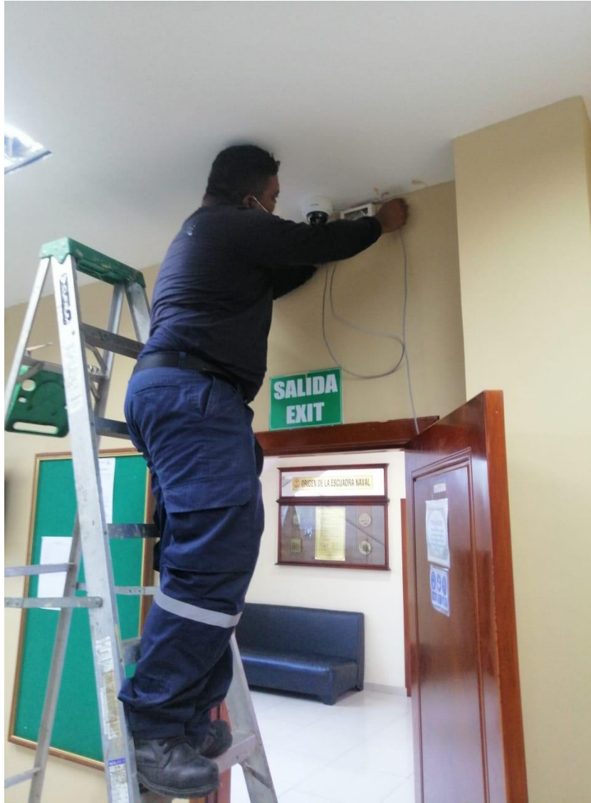
Figura 24 Instalación del cableado del sistema antihurto
