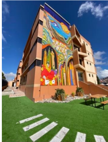
Figura 3.3: Vista frontal del edificio “Padre Juan Bottasso”.
