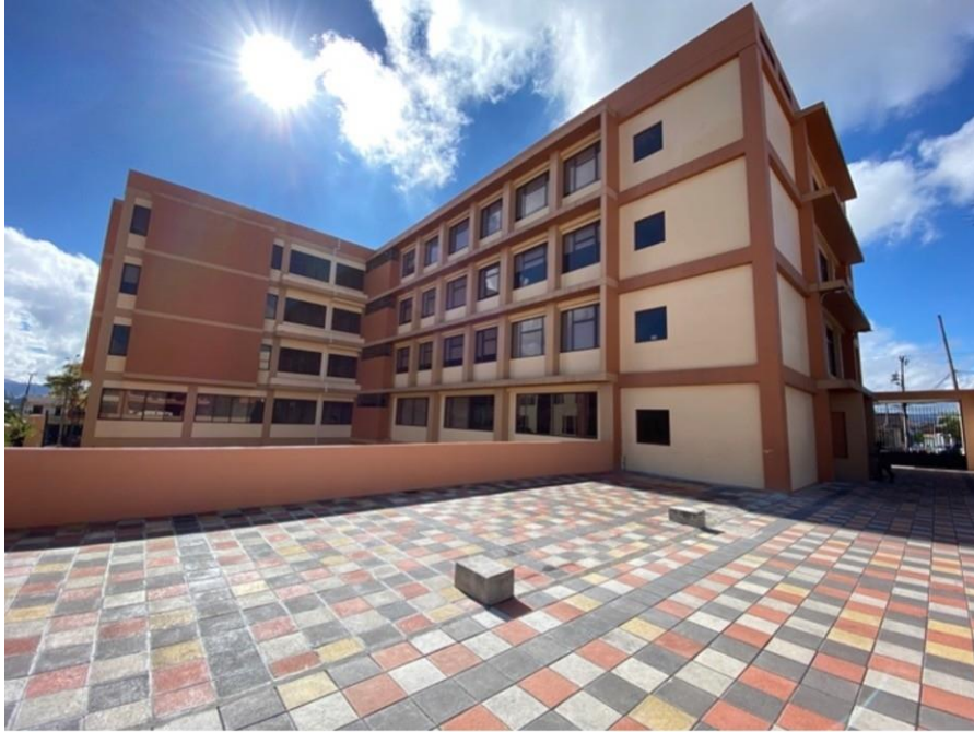
Figura 3.4: Vista posterior del edificio “Padre Juan Bottasso”.
