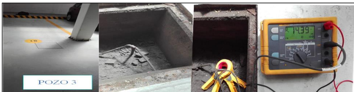
Figura 106: Medición del pozo 3. De izquierda a derecha se observa: (a) la ubicación del pozo en el parqueadero. (b) El pozo abierto. (c) La conexión para medir la resistencia. (d) La medición con el equipo.
