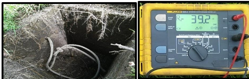
Figura 63: Revisión del pozo 5.
