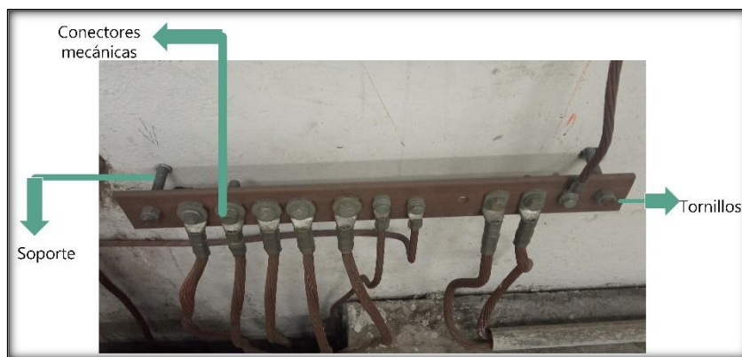
Figura 27: Barra equipotencial.
