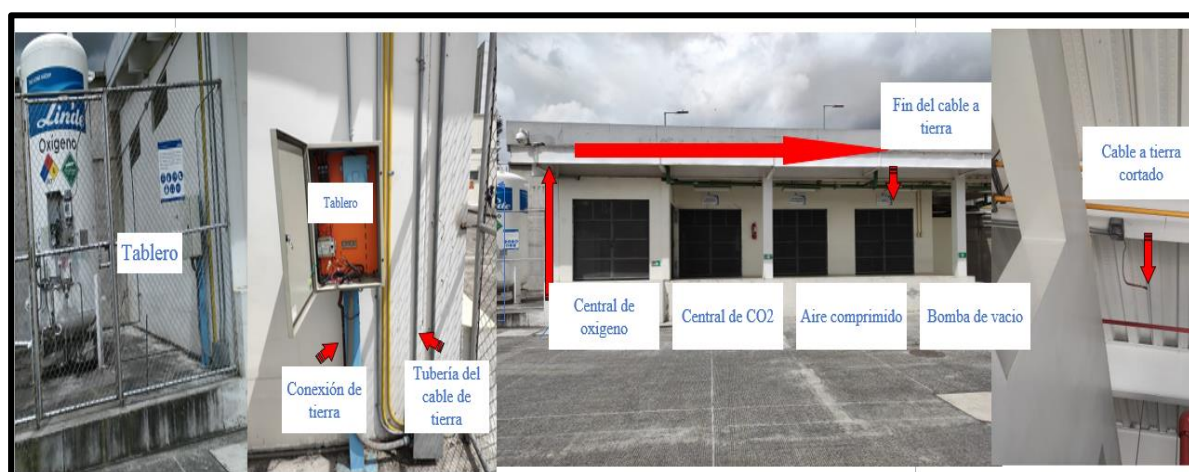
Figura 66: Revisión de conexión a tierra del tanque de oxígeno.
