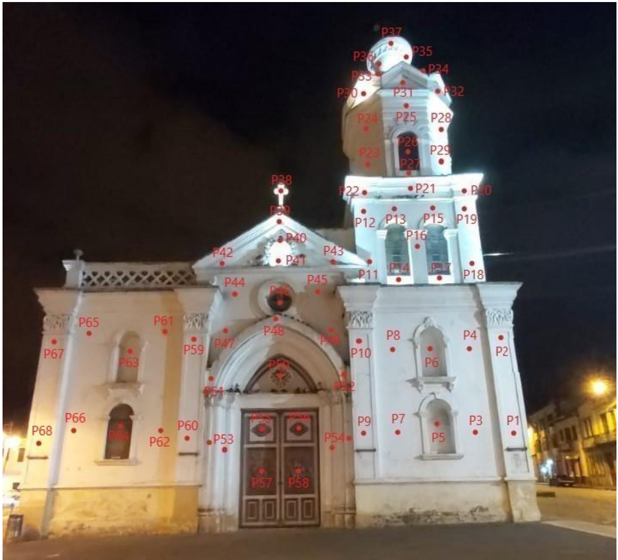
Fig. 27. Puntos de medición en la fachada fontal iglesia San Sebastián. [Autores]
