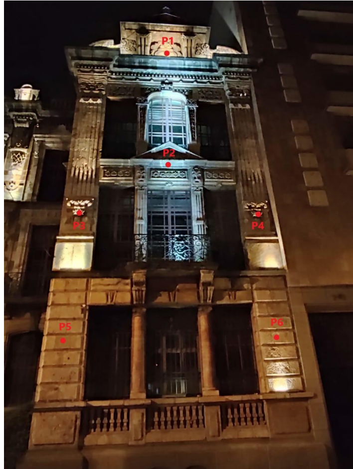
Fig. 82. Puntos de medición en la fachada lateral Bolívar 2 Alcaldía. [Autores]
