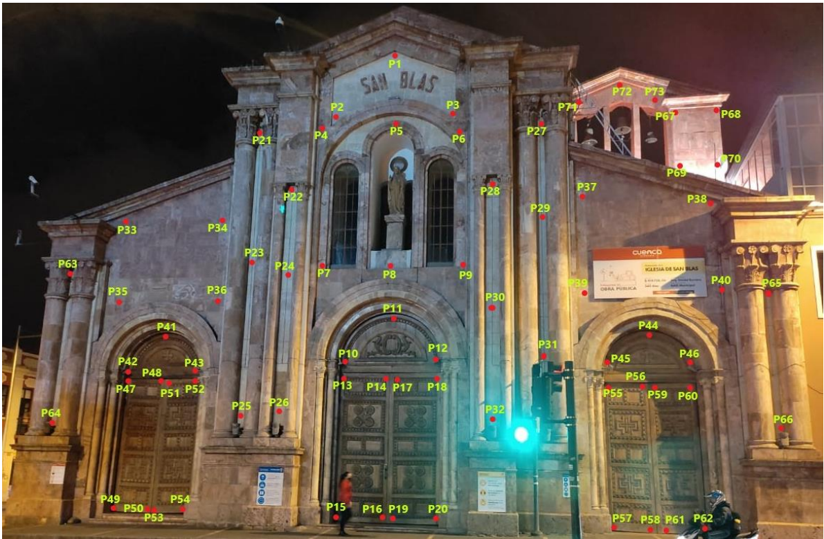
Fig. 36. Puntos de medición en la fachada frontal iglesia San Blas. [Autores]
