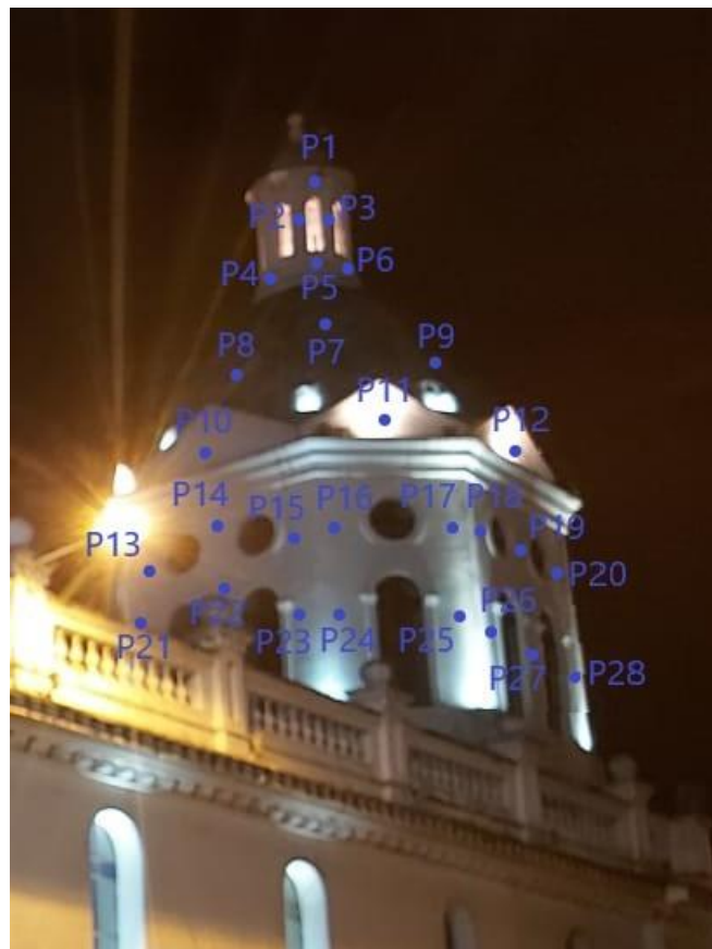
Fig. 29. Puntos de medición en la cúpula iglesia San Sebastián. [Autores]
