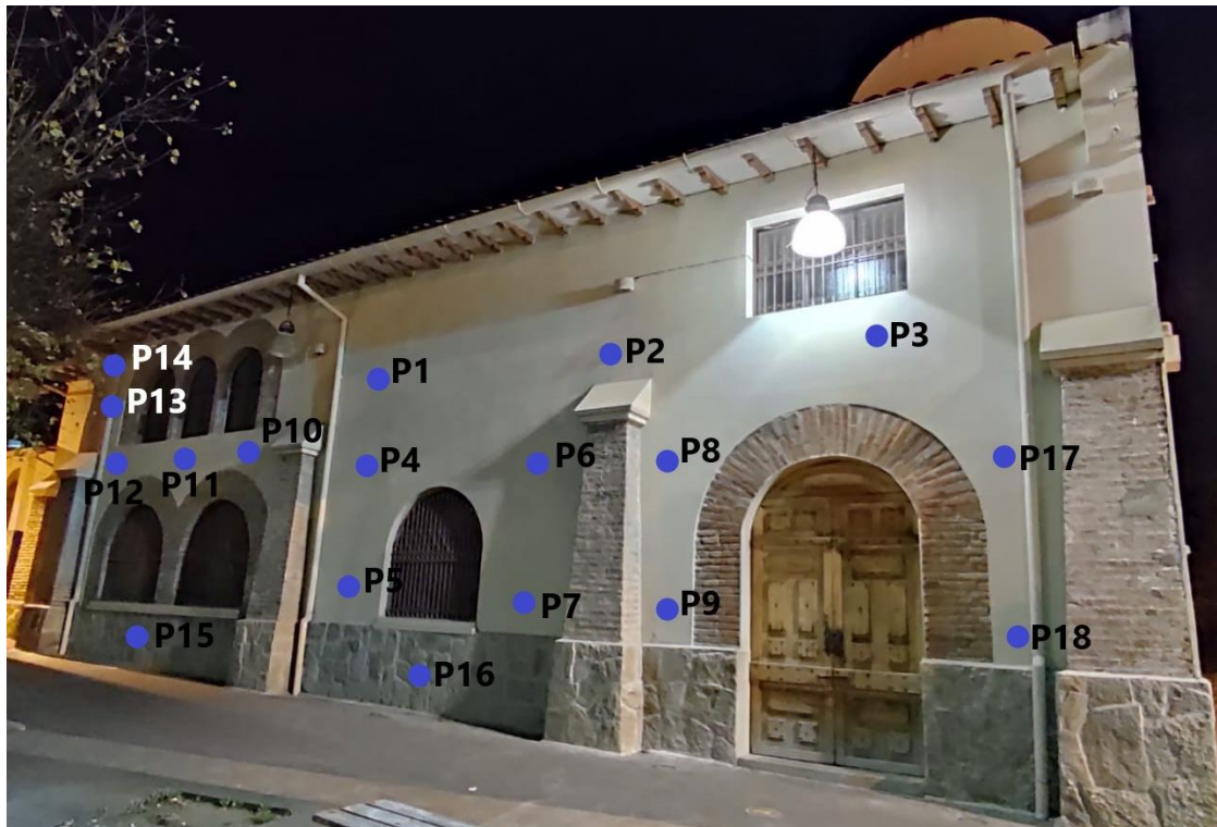
Fig. 56. Puntos de medición en la fachada lateral plazoleta iglesia El Vergel. [Autores]
