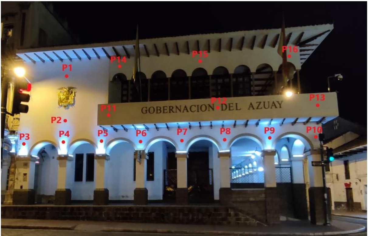
Fig. 72. Puntos de medición en la fachada frontal Gobernación del Azuay. [Autores]
