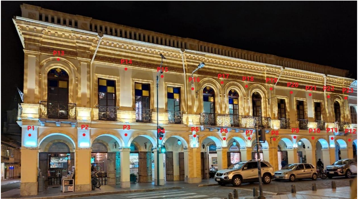
Fig. 68. Puntos de medición en la fachada frontal Casa del Parque. [Autores]
