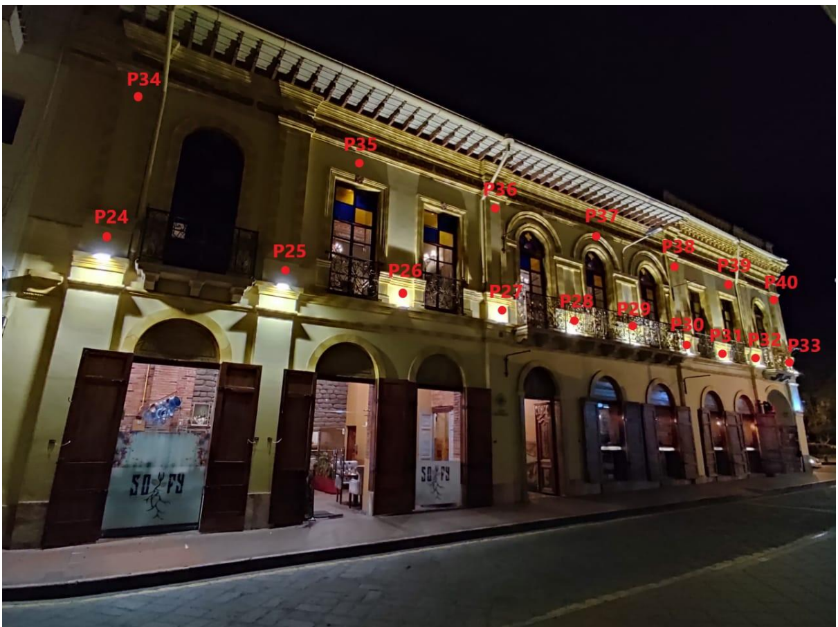
Fig. 69. Puntos de medición en la fachada lateral Casa del Parque. [Autores]
