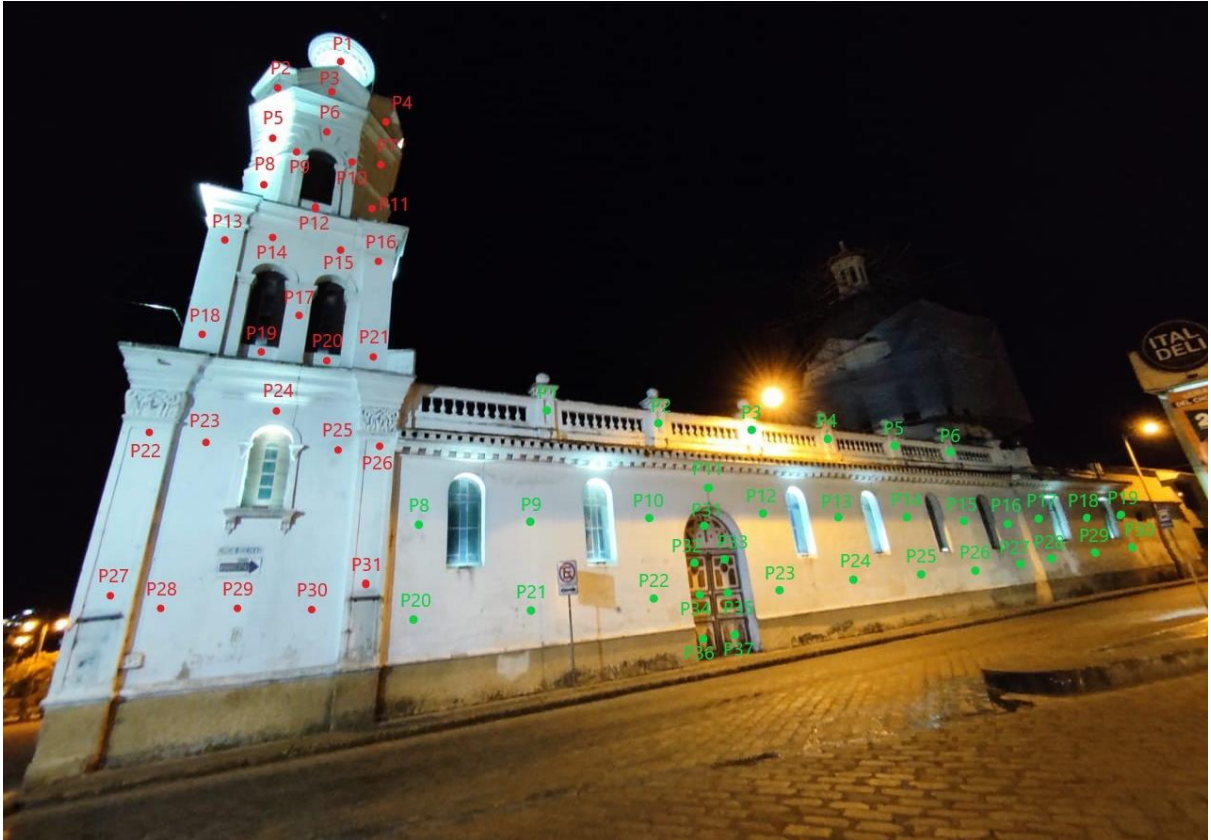
Fig. 28. Puntos de medición en la fachada lateral Bolívar iglesia San Sebastián. [Autores]
