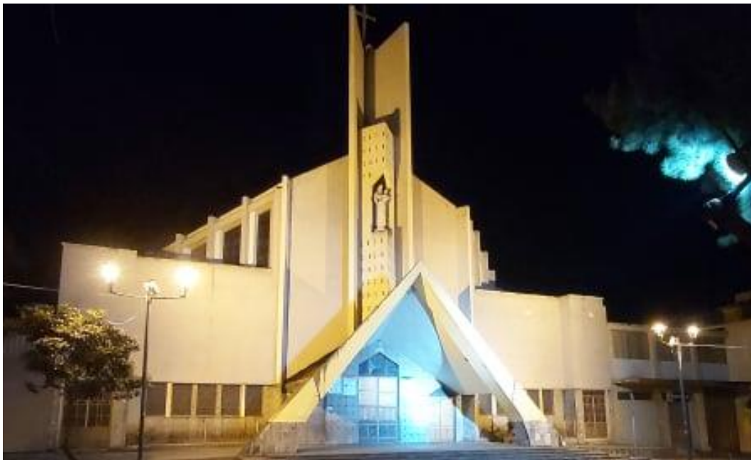
Fig. 14. Fachada de la iglesia de María Auxiliadora. [Autores]
