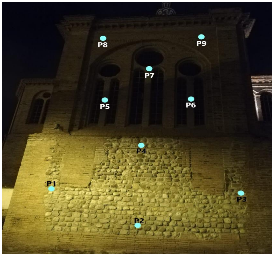
Fig. 37. Puntos de medición en la fachada lateral I iglesia San Blas. [Autores]
