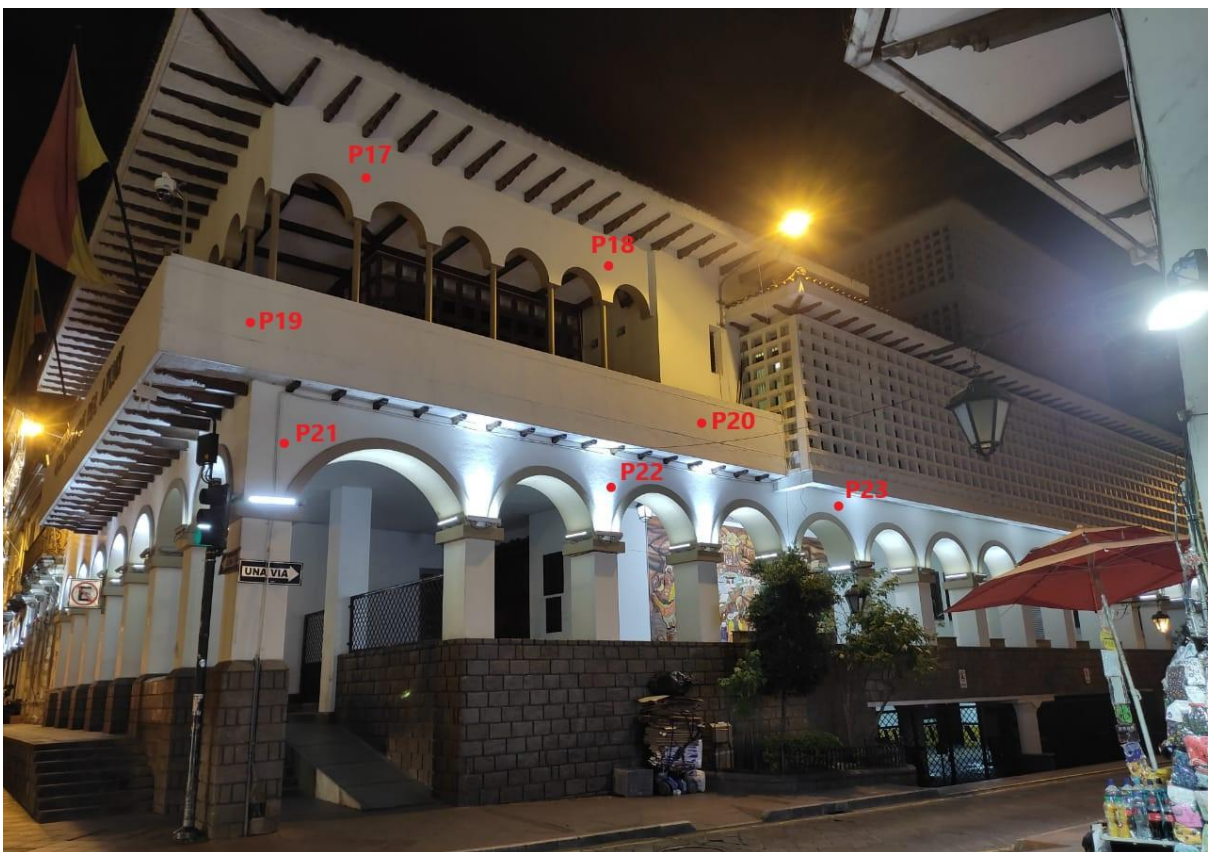
Fig. 73. Puntos de medición en la fachada lateral I Gobernación del Azuay. [Autores]
