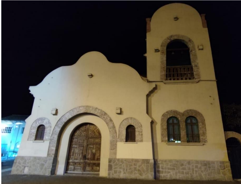
Fig. 13. Fachada de la iglesia Del Vergel. [Autores]
