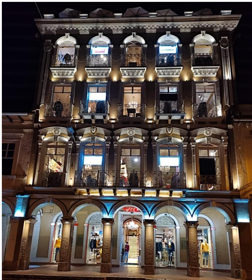
Fig. 18. Fachada del edificio de Vatex. [Autores]
