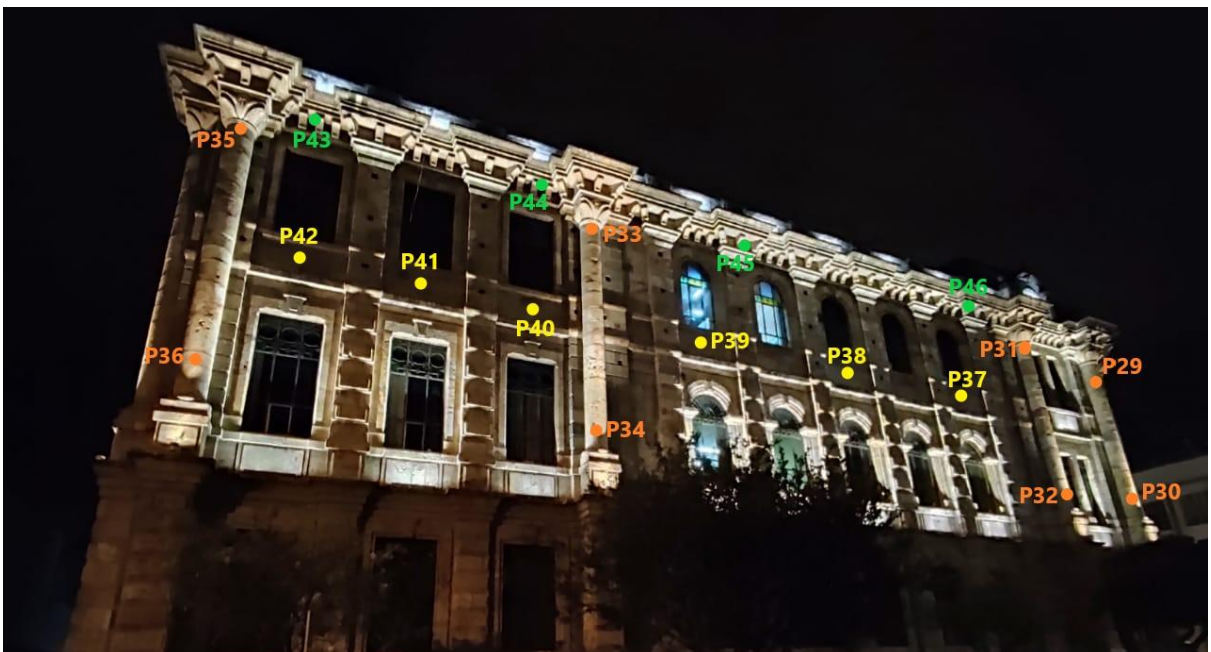
Fig. 63. Puntos de medición en la fachada lateral Sucre Corte Provincial de Justicia. [Autores]
