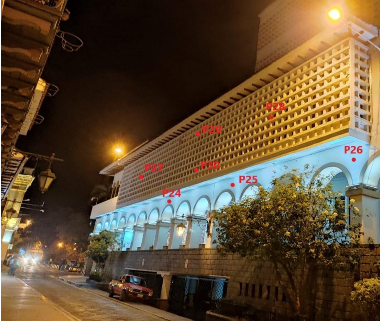
Fig. 74. Puntos de medición en la fachada lateral 2 Gobernación del Azuay. [Autores]
