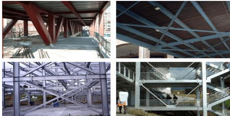
Figura 10: Colocación de la cruz de San Andres
