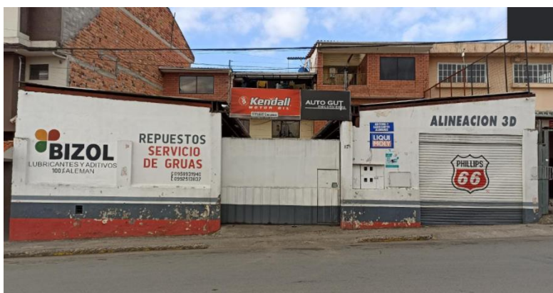
Fachada de Autogut Mecanicentro
