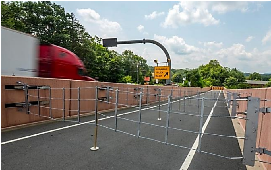
Figura 34. zona de frenado implementado el sistema TAS
