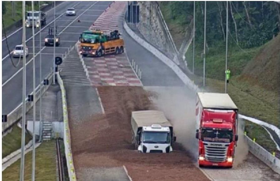
Figura 7. Zona de frenado de emergencia.
