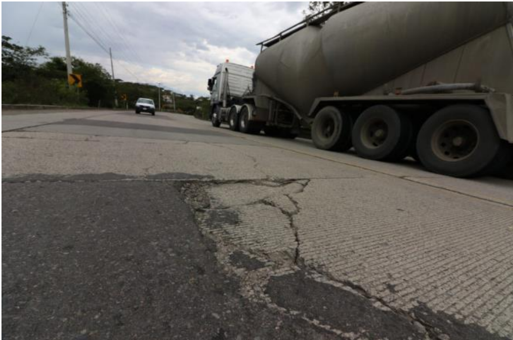
Figura 11. Vehículo con carga completa vía Girón.
