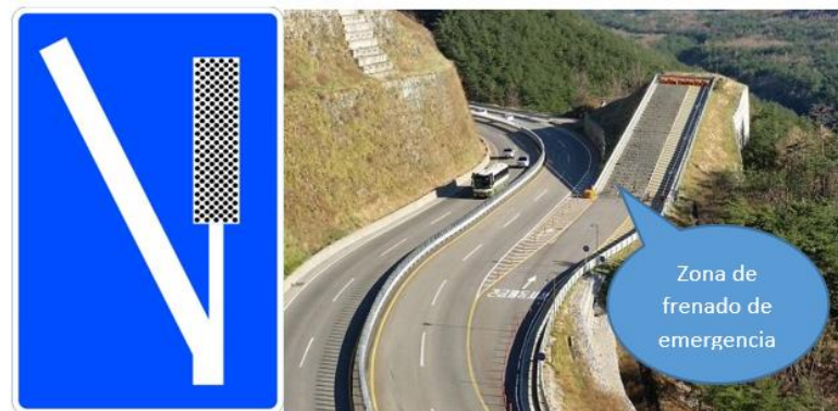
Figura 6. Señalética (izquierda.), Zona de frenado de emergencia (derecha).
