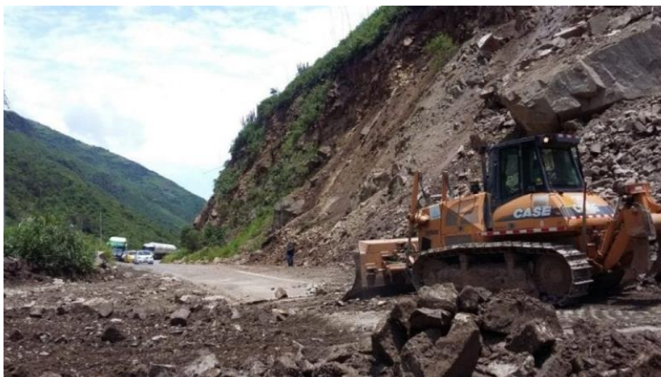
Figura 20. limpieza de vía por parte de maquinaria del MTOP
