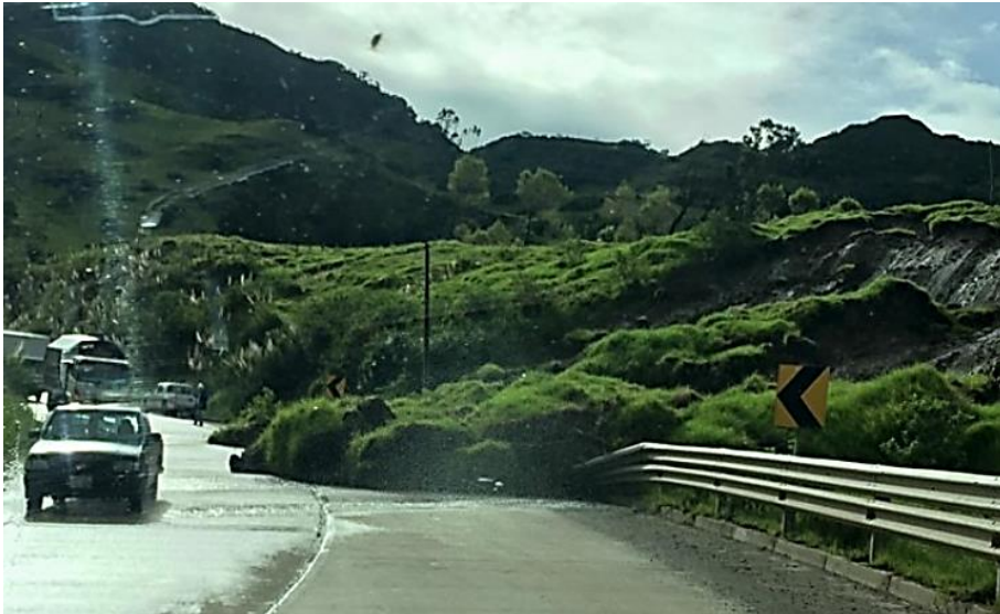
Figura 19. Derrumbos en la vía Girón, sector del Cáñaro.
