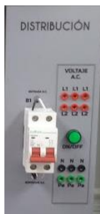
Figura 3.27. Lámina de distribución terminada.
