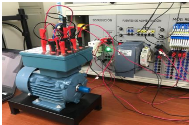
Figura 21. Motor conectado al tablero.
