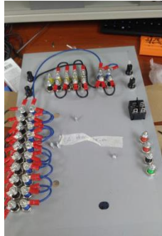
Figura 3.29. Cableado de elementos hacia los puertos de conexión.
