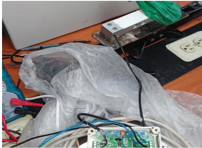
Figura 3.52. Toma de voltaje para comprobar funcionamientos.
