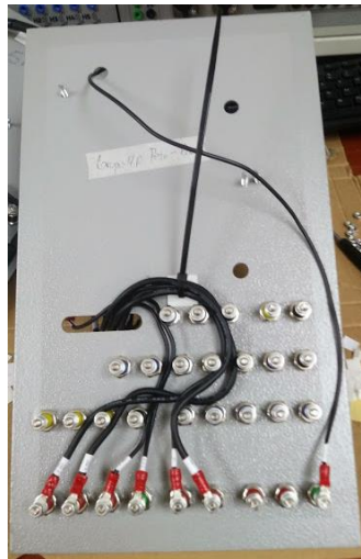
Figura 3.36. Cableado de salida y entradas del variador hacia puntos de conexión.
