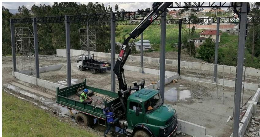
*Figura 67 Montaje de amarres de columna a columna*
