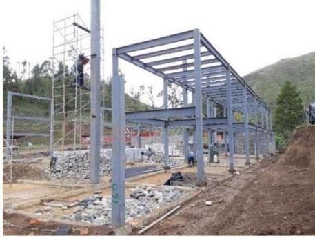
*Figura 9 Montaje de estructura metálica Fuente: Autor*
