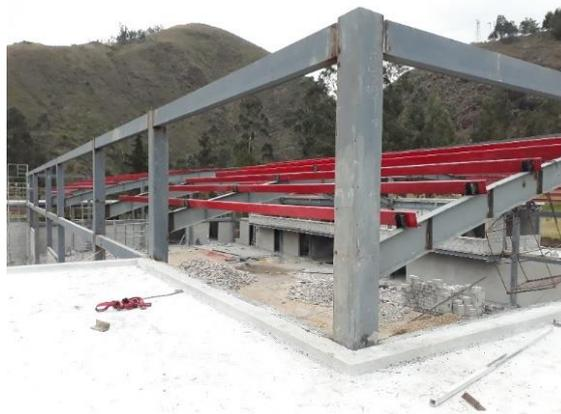
*Figura 12 Pintado de estructura de color rojo según especificaciones. Fuente: Autor*
