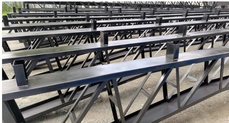
Figura 64 Recepción de pórticos al lugar de montaje
