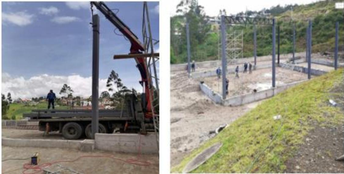
*Figura 66 Montaje de columnas principales de la bodega de residuos especiales*
