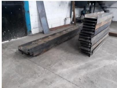
*Figura 10 Vigas secundarias apiladas hasta que se realice su respectivo montaje Fuente: Autor*
