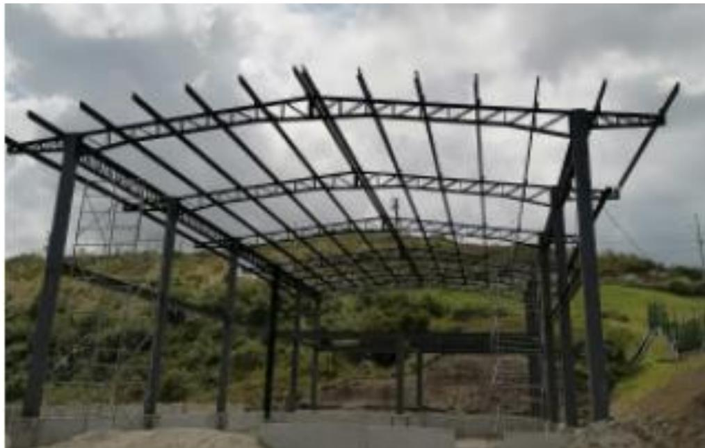
*Figura 70 Infraestructura metálica terminada con todos los detalles constructivos según el plano estructural*
