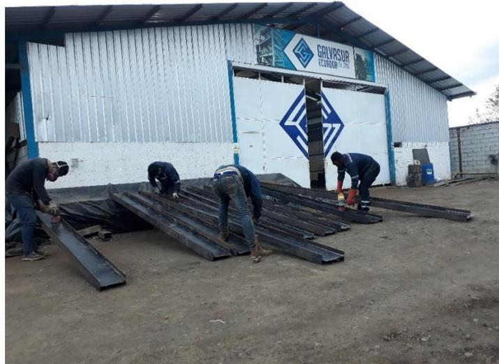
*Figura 14 Limpieza y pintado de vigas metálicas. Fuente: Autor*
