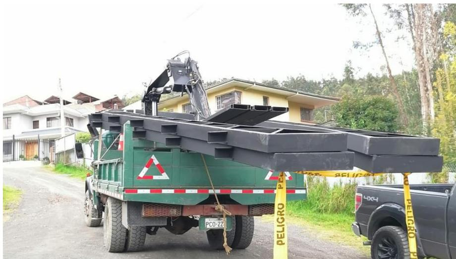
*Figura 62 Transporte de pórticos al lugar de montaje*
