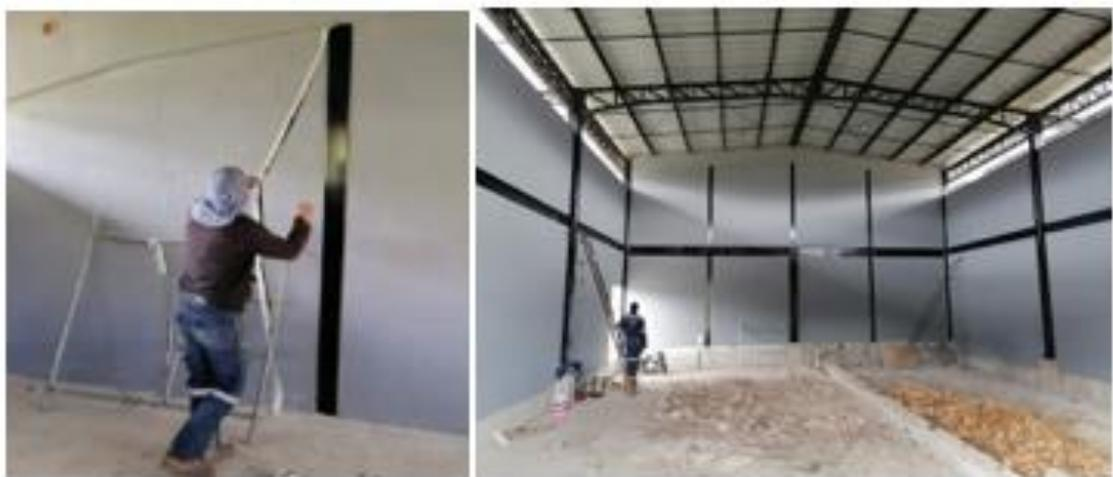
*Figura 69 Correcciones de pintura en la estructura metálica*
