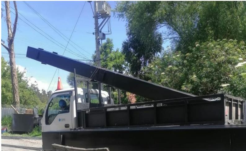
*Figura 61 Transporte de columnas al lugar de montaje*
