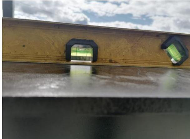
*Figura 68 Verificación de nivel en viga metálica*
