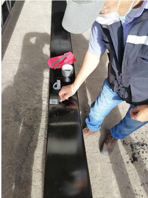
Figura 57 Control de adherencia parte de fiscalización
