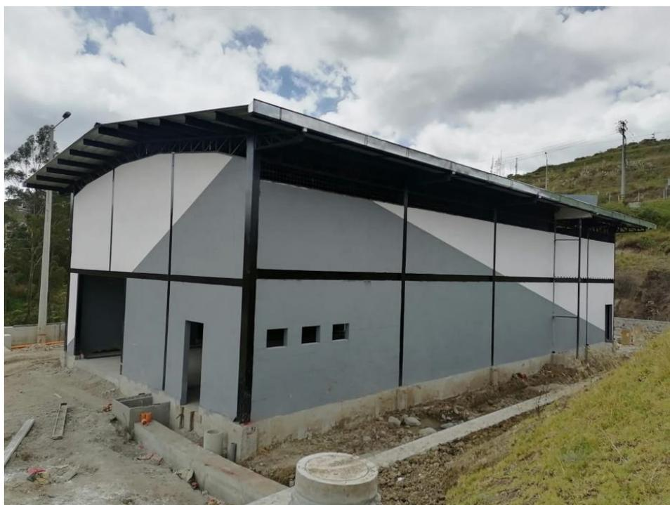
*Figura 71 Nave de residuos especiales terminada con mampostería y estructura metálica vista.*
