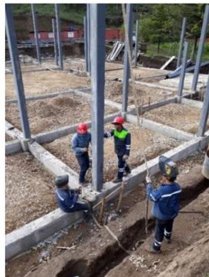
*Figura 11 Montaje de columnas mediante soldadura a placa base Fuente: Autor*
