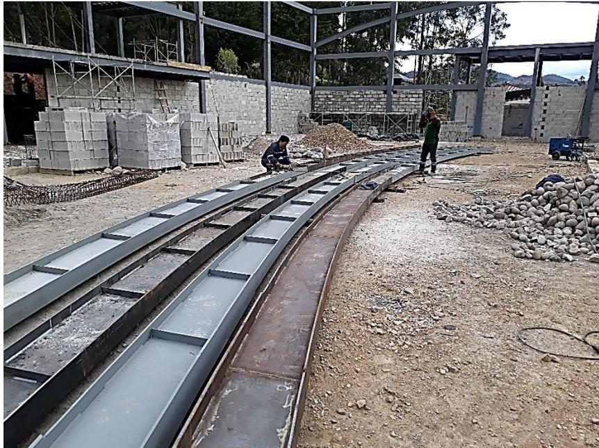
*Figura 1 Inadecuada organización de los procesos constructivos y montaje en obra. Fuente: Autor*
