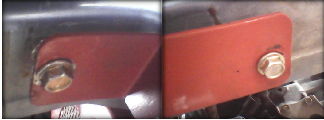
Fig. 4.36. Sujeción de las tuberías de ventilación a la carrocería. Fuente: Los Autores.
