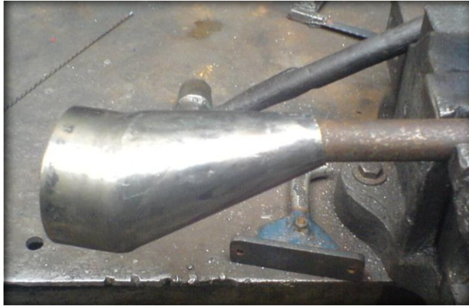
Fig. 4.11. Reducción de la sección de tubería de ventilación. Fuente: Los Autores.
