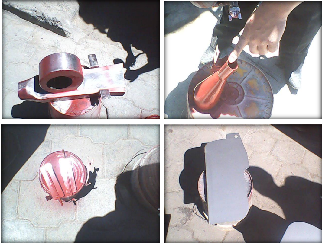
Fig. 4.13. Pintado de las tuberías, obturadores de aire y elementos de sujeción.
