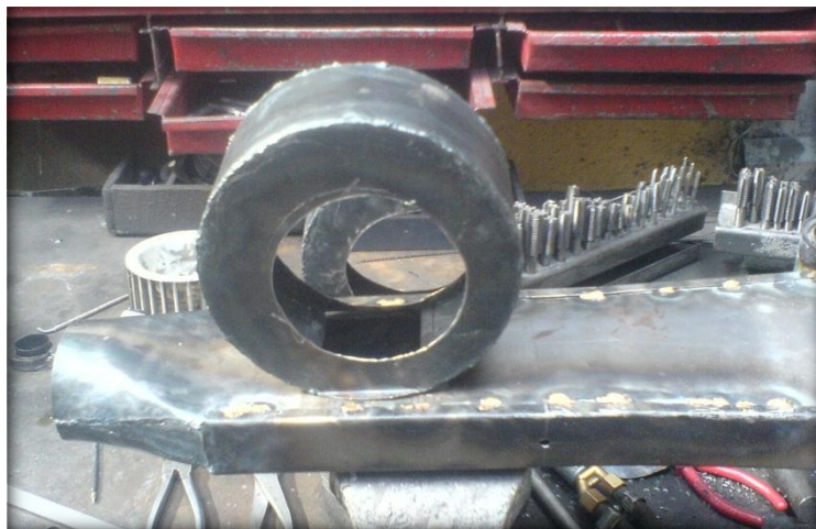
Fig. 4.6. Ensamble del caracol del electro ventilador sobre la tubería. Fuente: Los Autores.
