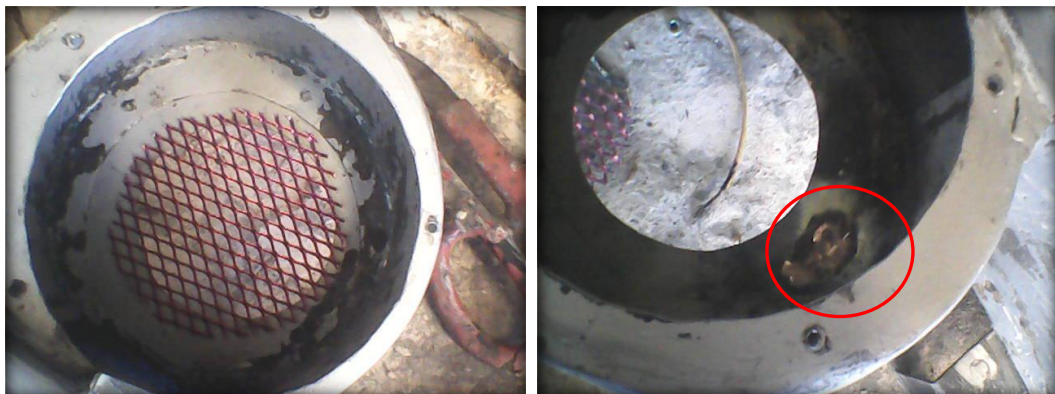
Fig. 4.8. Seguros de malla de protección del ventilador. Fuente: Los Autores.
