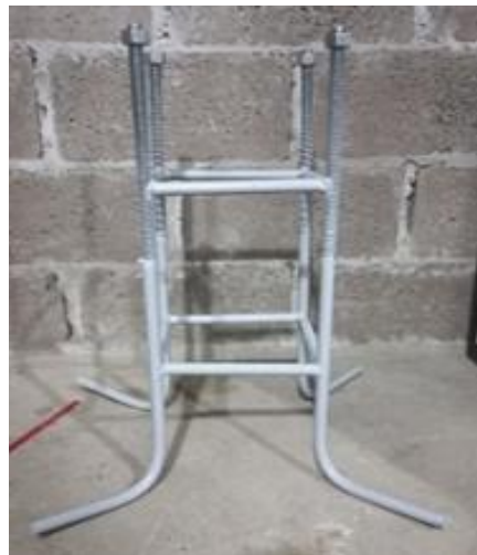
Figura 41. Canastilla formada con hierro galvanizado.
