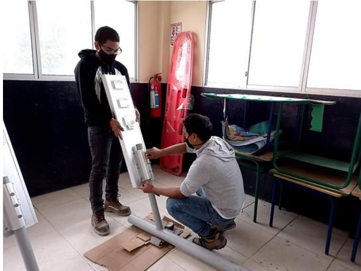
Figura 50. Ajustando la lampara a la base del poste.
