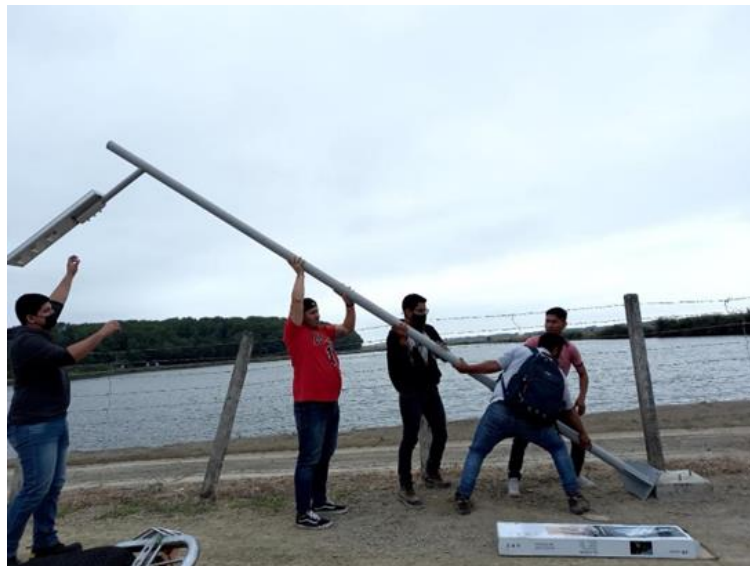
Figura 51. Colocación del poste con la base.
