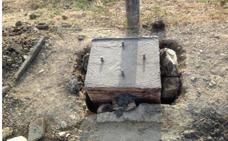
Figura 48. Base del poste.
