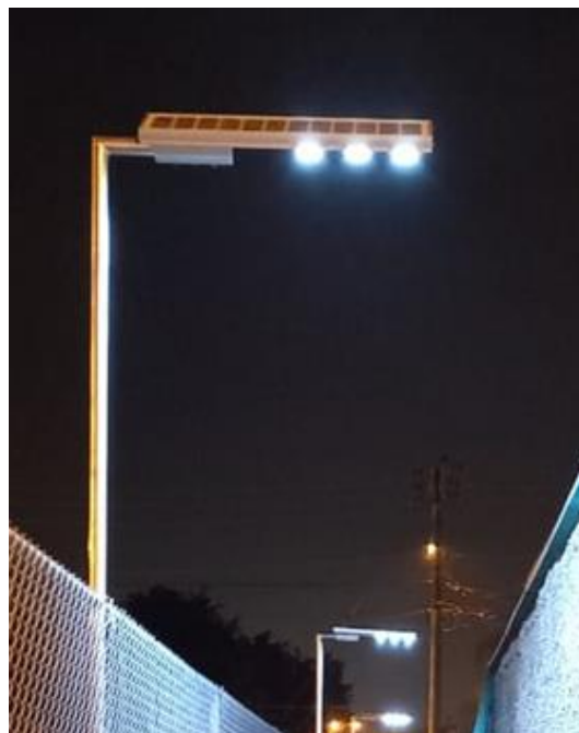
Figura 43. Prueba de luminaria.
