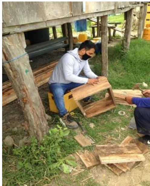
Figura 47. Realización de los cajones para la base.
