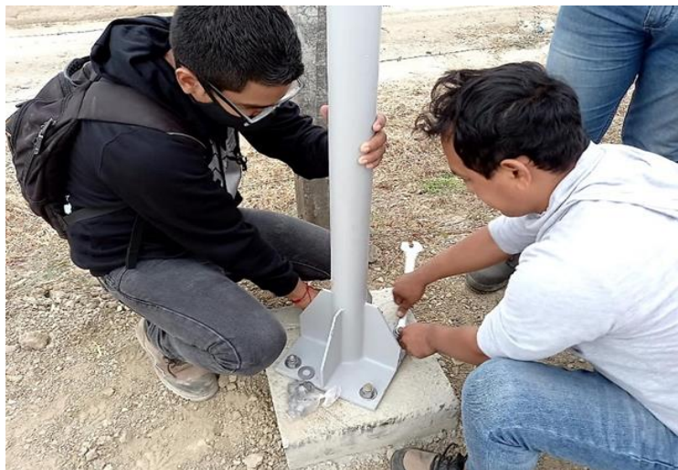
Figura 52. Atornillado del poste con la base.
