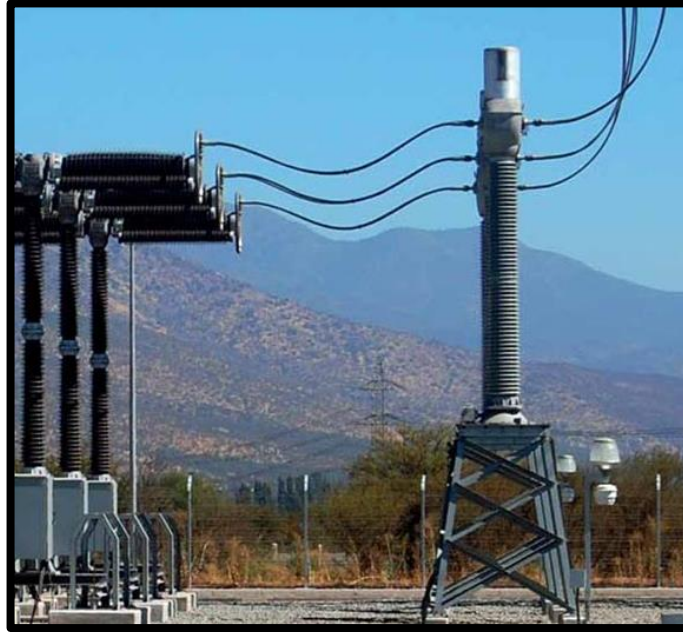
FIGURA 14: INTERRUPTOR DE POTENCIA SIEMENS [21]
