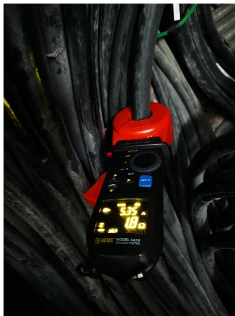
Figura 21 Medición del SPT con pinza teluro métrica de bucle
