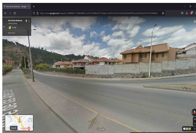
Figura 3.6: Infraestructura cuadra dos en Google Maps
