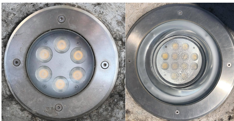
Figura 2.17: Luminaria ornamental de 25 W y 36W Led.
