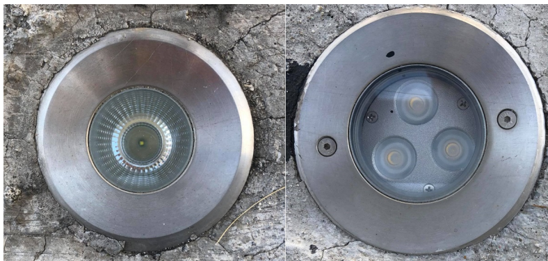
Figura 2.16: Luminaria ornamental de 3.6 W y 15W Led.
