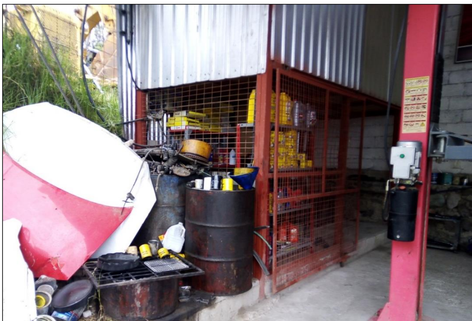
Figura 20. Área depósitos de aceites Fuente: El autor
