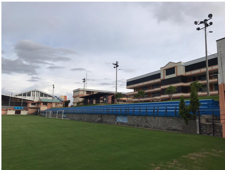
Figura 20. Torres de iluminación
