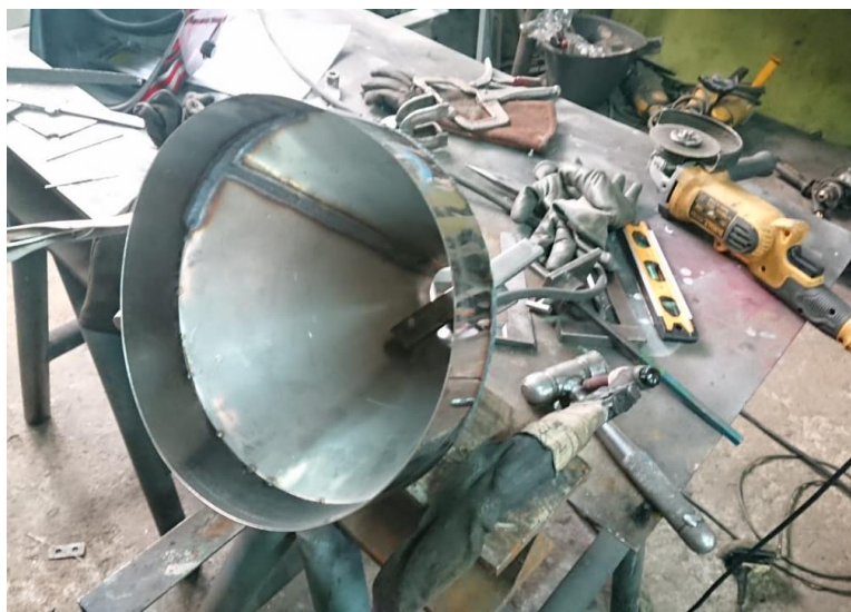
La imagen muestra el proceso de armado de la tolva de alimentación.
