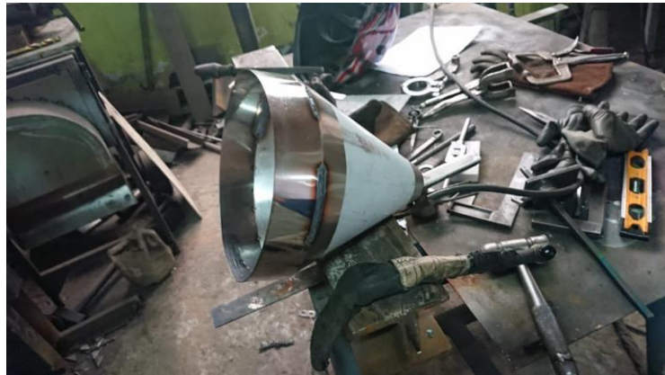
Figura 65. Construcción de la tolva de alimentación. Fuente: Autor
