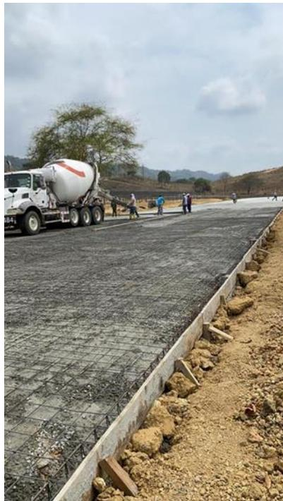
*Figura 6 Fundición de plataformas*
