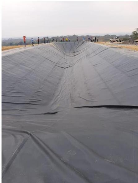
*Figura 9 Construcción de cisterna*
