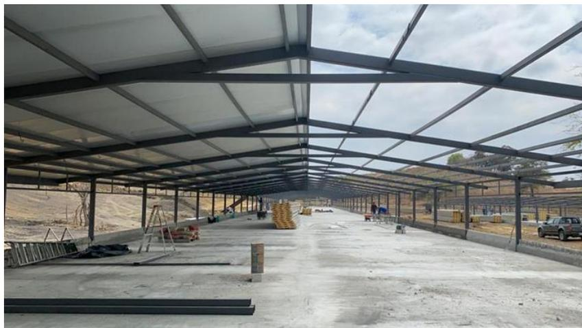
*Figura 8 Instalación de cubierta aislada*
