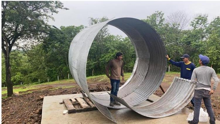
*Anexo 9 Armado de silos de almacenamiento para balanceado*
