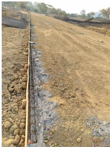
*Anexo 4 Elaboración de plintos, riostras y encofrados para fundición*
