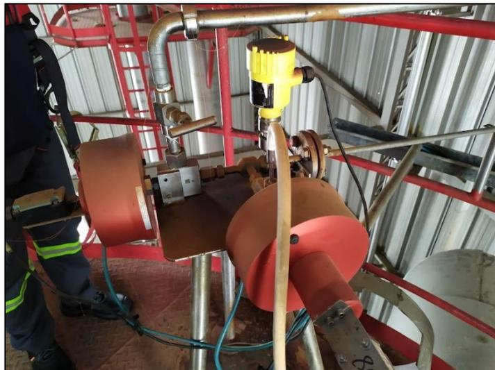
Figura 17. Sistema de alimentación en la parte superior de la torre de secado
