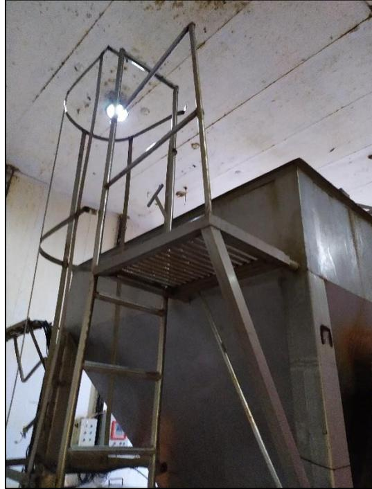
Figura 21. Vista de protección colectiva incompleta en plataforma de tolva mayor
