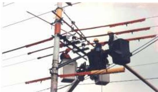
Fig25. Trabajos en líneas energizadas
