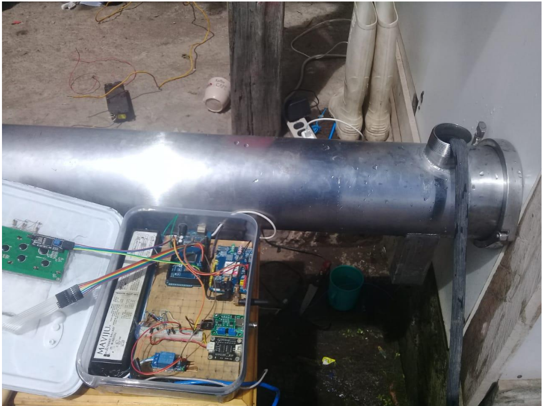
Fig.B 3 Montaje de módulos de comunicación [Fuente: Autor].
