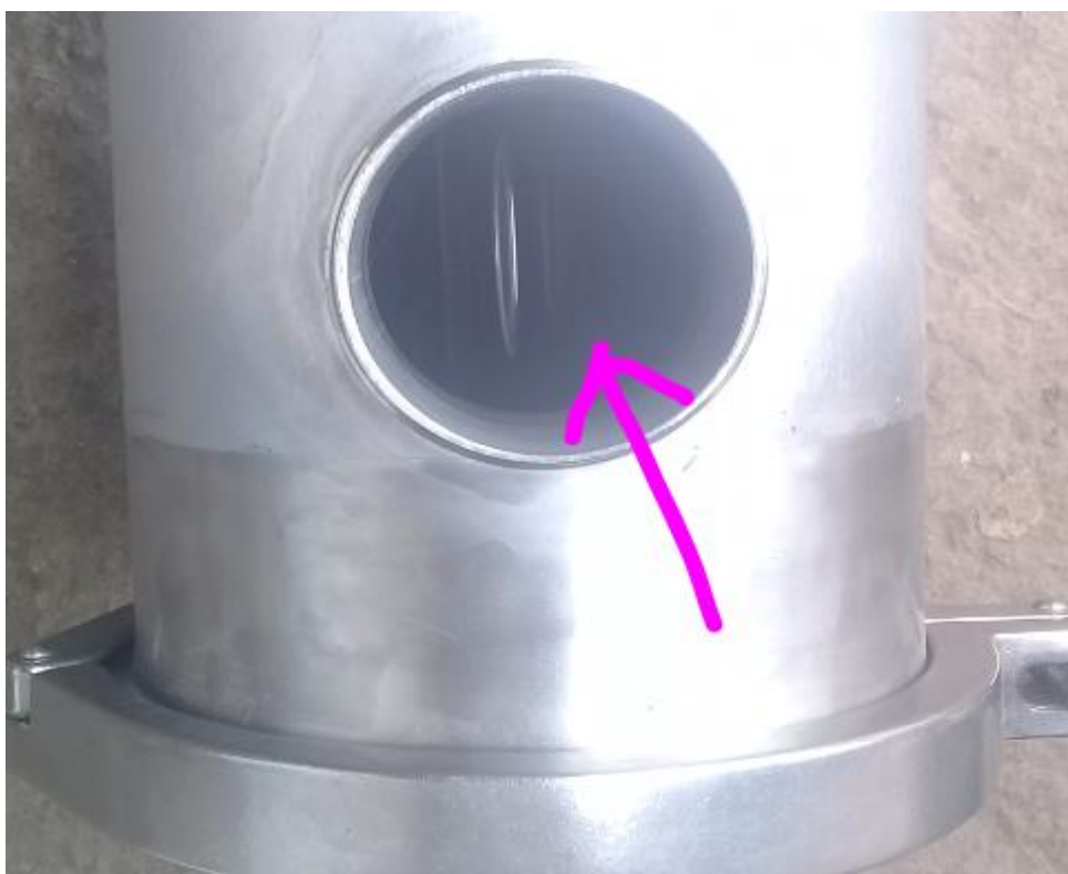
Fig.3 12 Instalación de lámpara dentro del Reactor [Fuente: Autor].
