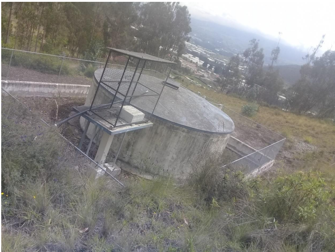
Fig.F 1 Reservorio secundario ingreso de agua de todas las vertientes [Fuente: Autor].
