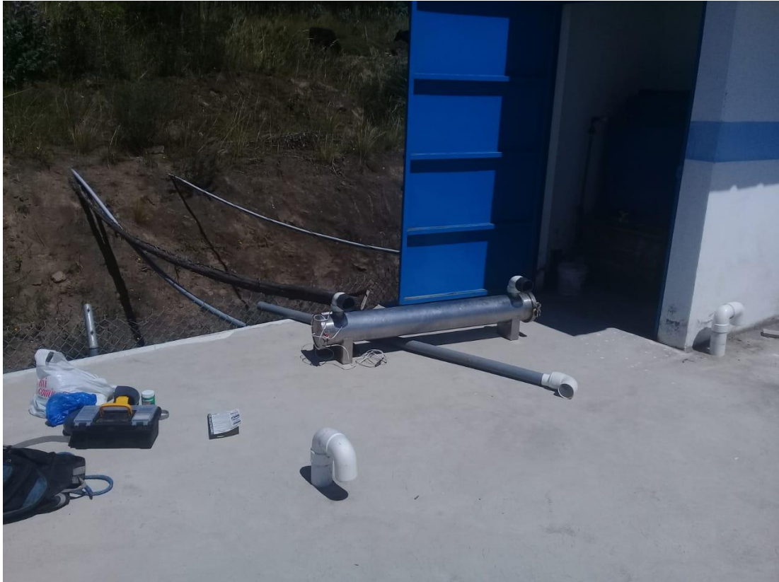
Fig.F 4 Adecuación del lugar de implementación [Fuente: Autor].
