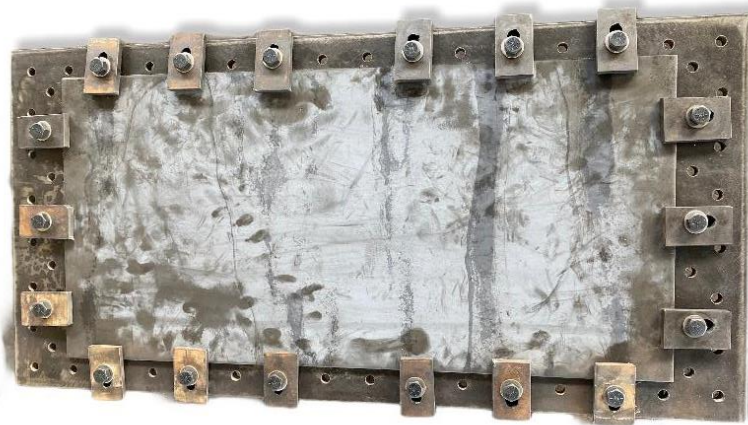
FIGURA 47. Entenalla final con la placa montada.
