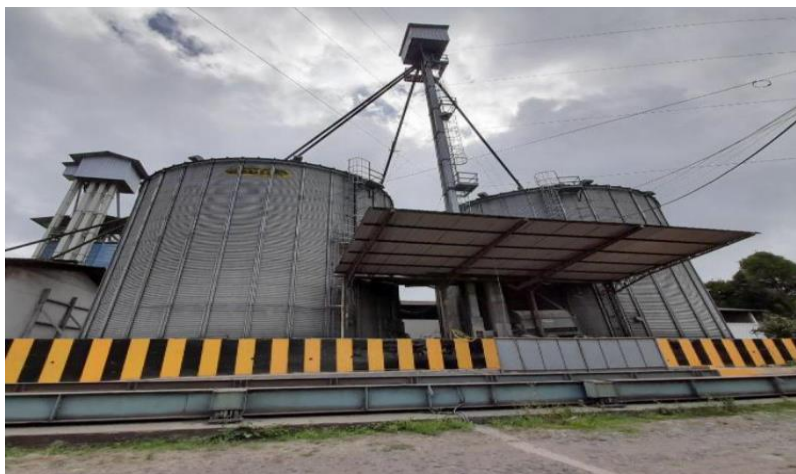
Figura 4. Planta de Balanceados ubicado en Puenbo, Silos de Maíz. Fuente: Autor.
