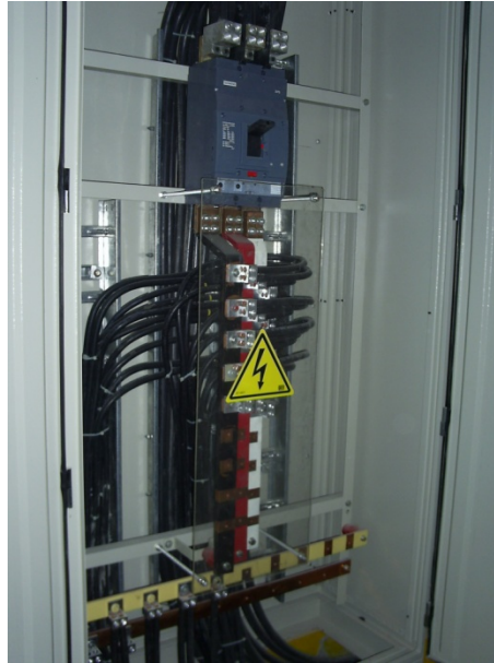
Foto 5.1 UPS-G Nuevo Campus (Panel Principal)
