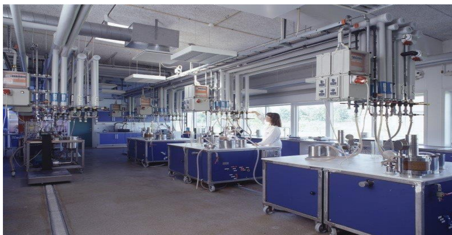
Figura 13 Filtración por Membrana
