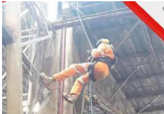
Figura 13: Instalación de sellos
