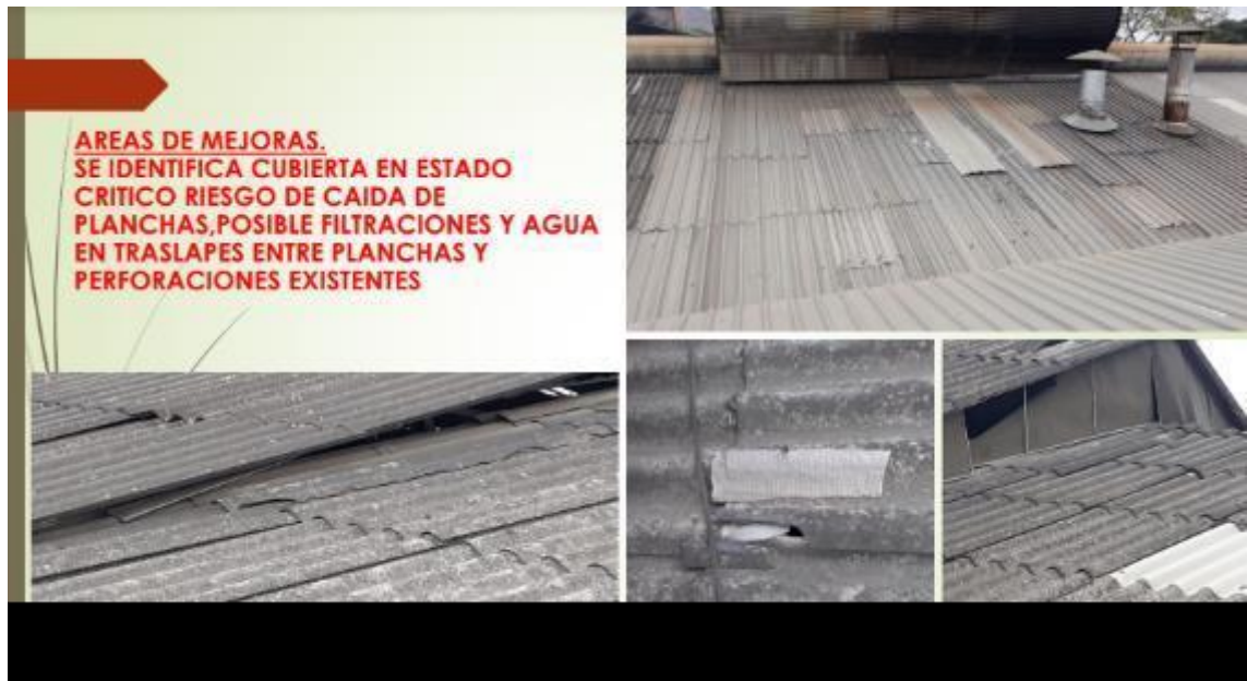
Figura 4: Informe de inspeccion.
