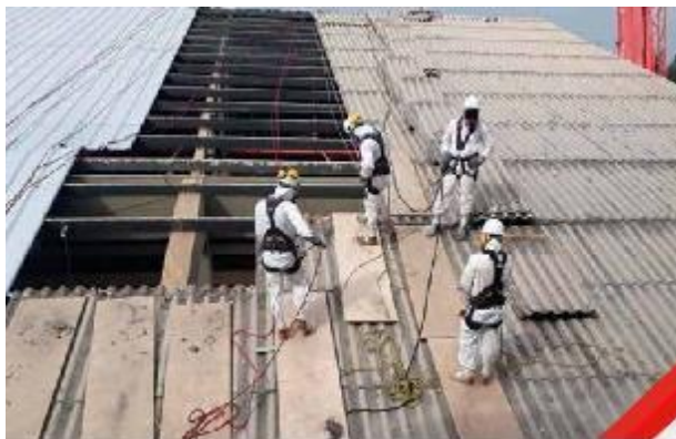
Figura 12: Instalación de Steel Panel.
