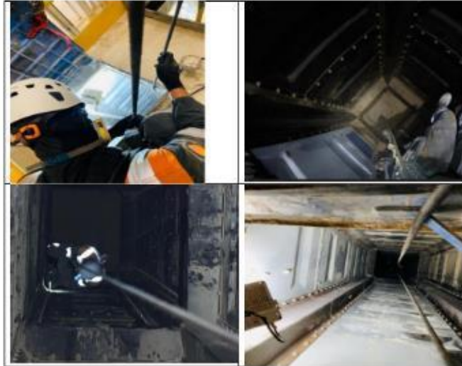
Figura 3: Informe de intervencion.
