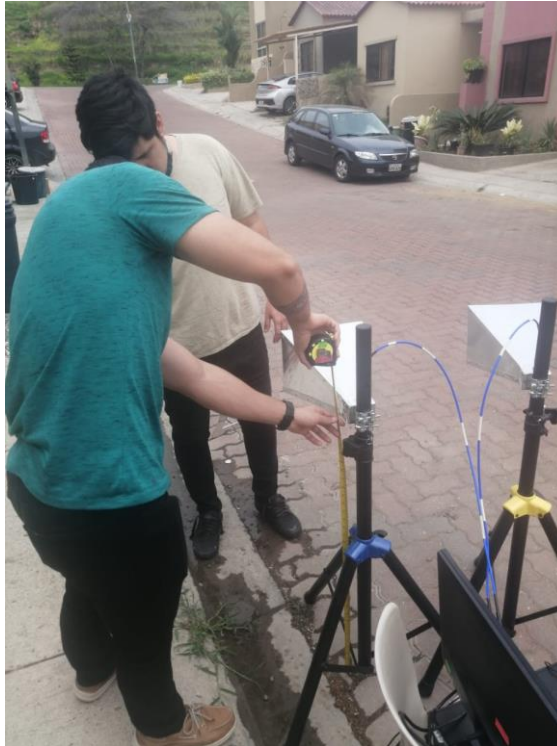
Figura 4.33 Ajustes en altura de antenas
