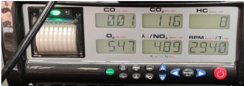
Ilustración 39 Analizador de gases
