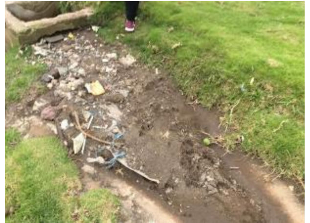
Muro de retención de escombros y rejillas sin mantenimiento
