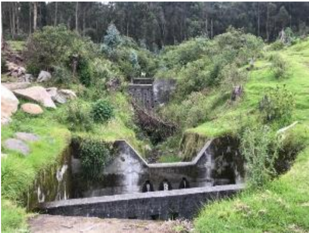
Muro de retención de escombros y rejillas sin mantenimiento
