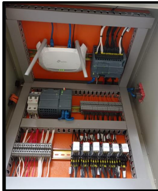
Figura 69 Vista frontal real del módulo PLC S7 1200
