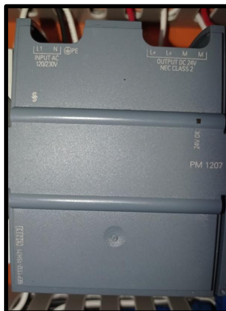
Figura 27 Fuente SIEMENS conmutada 110VAC a 24Vdc / 2.5Amp
