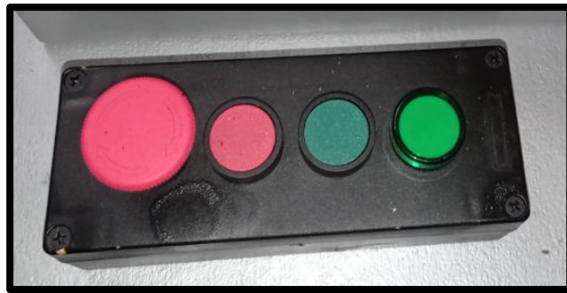
Figura 45 Botoneras de control de la Planta ET 200SP
