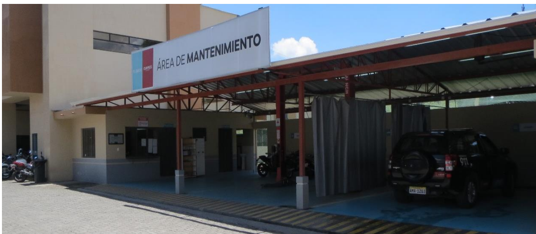
Figura 2.3 Área de Mantenimiento
