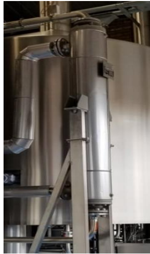
Figura 12. Intercambiador de calor de tubos y coraza.
