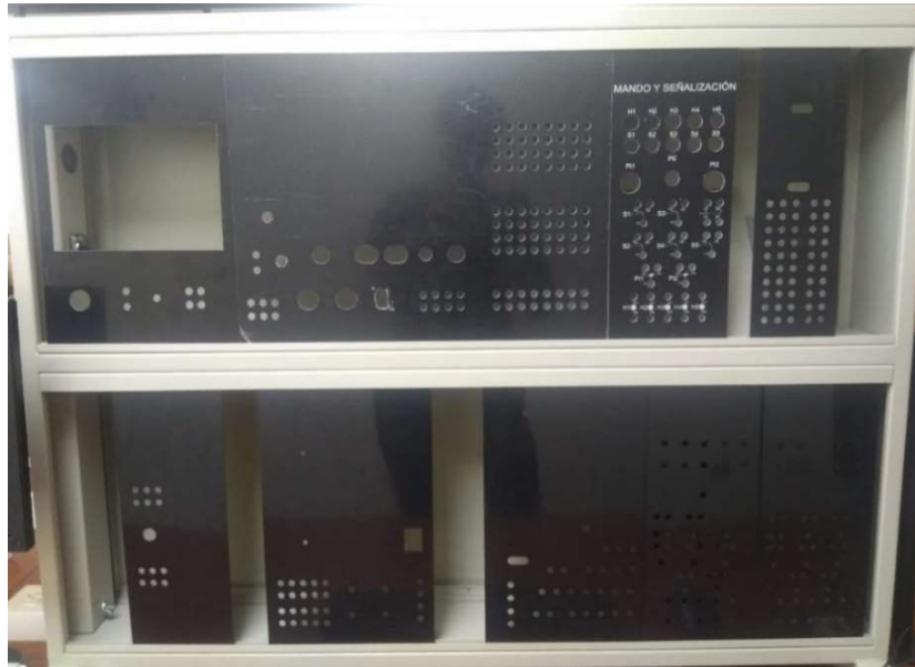
Figura 49. Láminas demostrativas instaladas en la estructura aprobada.
