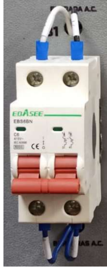
Figura 35. Disyuntor bifásico.
