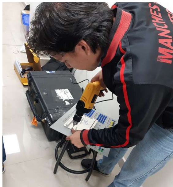
Figura 67. Instalación de soporte Riel Din para el PLC.
