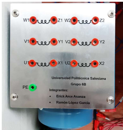
Figura 53. Instalación de Placa del Motor y plugs hembra.
