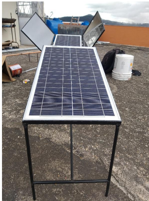
Ilustración 37: Montaje de los paneles con y sin espejos.
