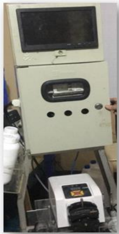
Figura 46. Colocación de tablero en la estructura.
