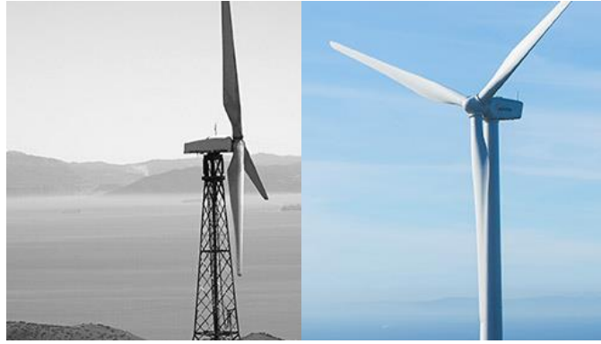
Figura 4. (a) Torre Celosía, (b) Torre Tubular
