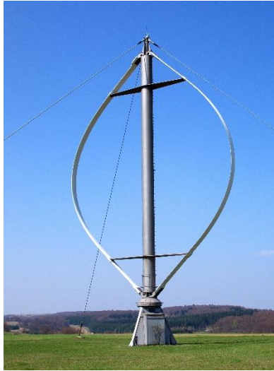
Figura 1. Aerogenerador de eje Vertical (Darrieus)
