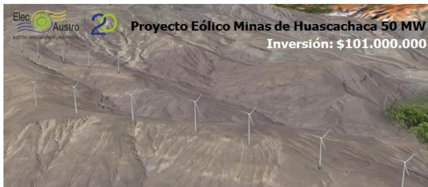
Figura 1.13 Proyecto eólico minas de Huascachaca (ELECAUSTRO, 2020).
