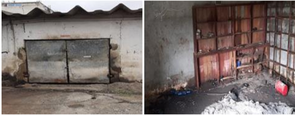
Figura 25. (Izquierda) Bodega principal del taller municipal Machala, (Derecha) Bodega secundaria del taller municipal Machala. Fuente: Autores.
