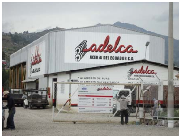
Figura 4.5. Instalaciones de Adelca en la ciudad de Cuenca.
